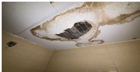
Mould on ceiling tile (washroom 3033A)
